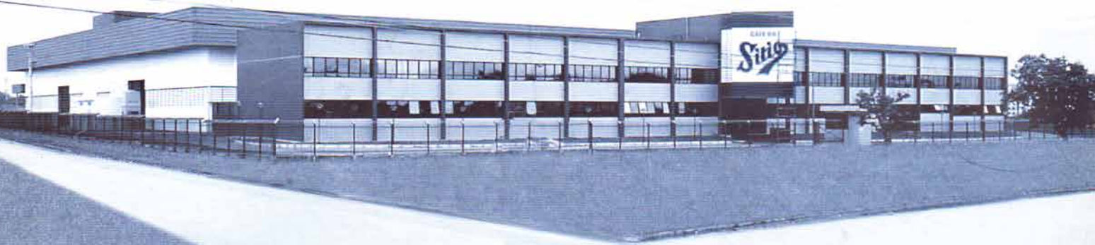
Nova fábrica: 16 mil m 2 de área construída e equipamentos 100% Lilla.
